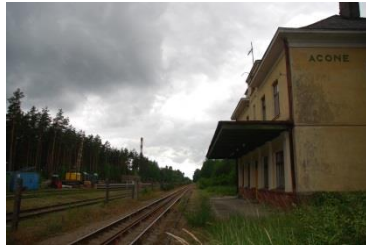
34. attēls. Esošā dzelzceļa līnija pie Acones stacijas
