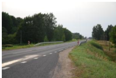
44. attēls. Autoceļa P85 šķērsojuma vieta
